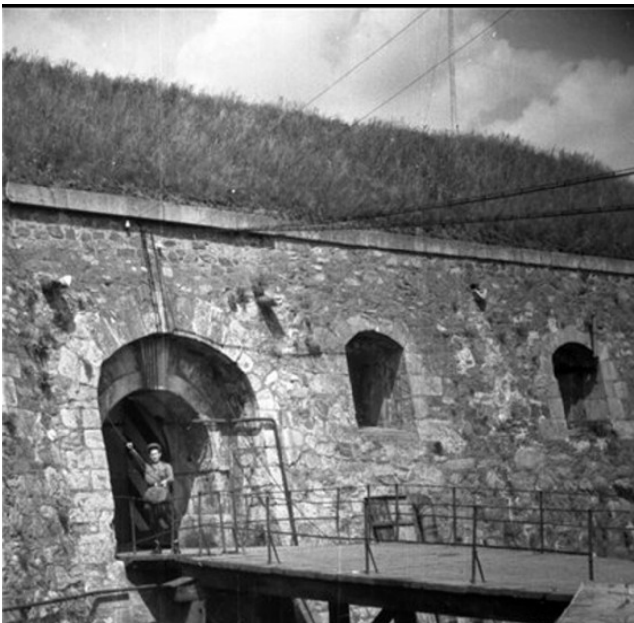
Brama poterny południowej Donjonu od Przeciwnastry. Widoczne odwodnienie kanałów pachowych na zewnątrz.
