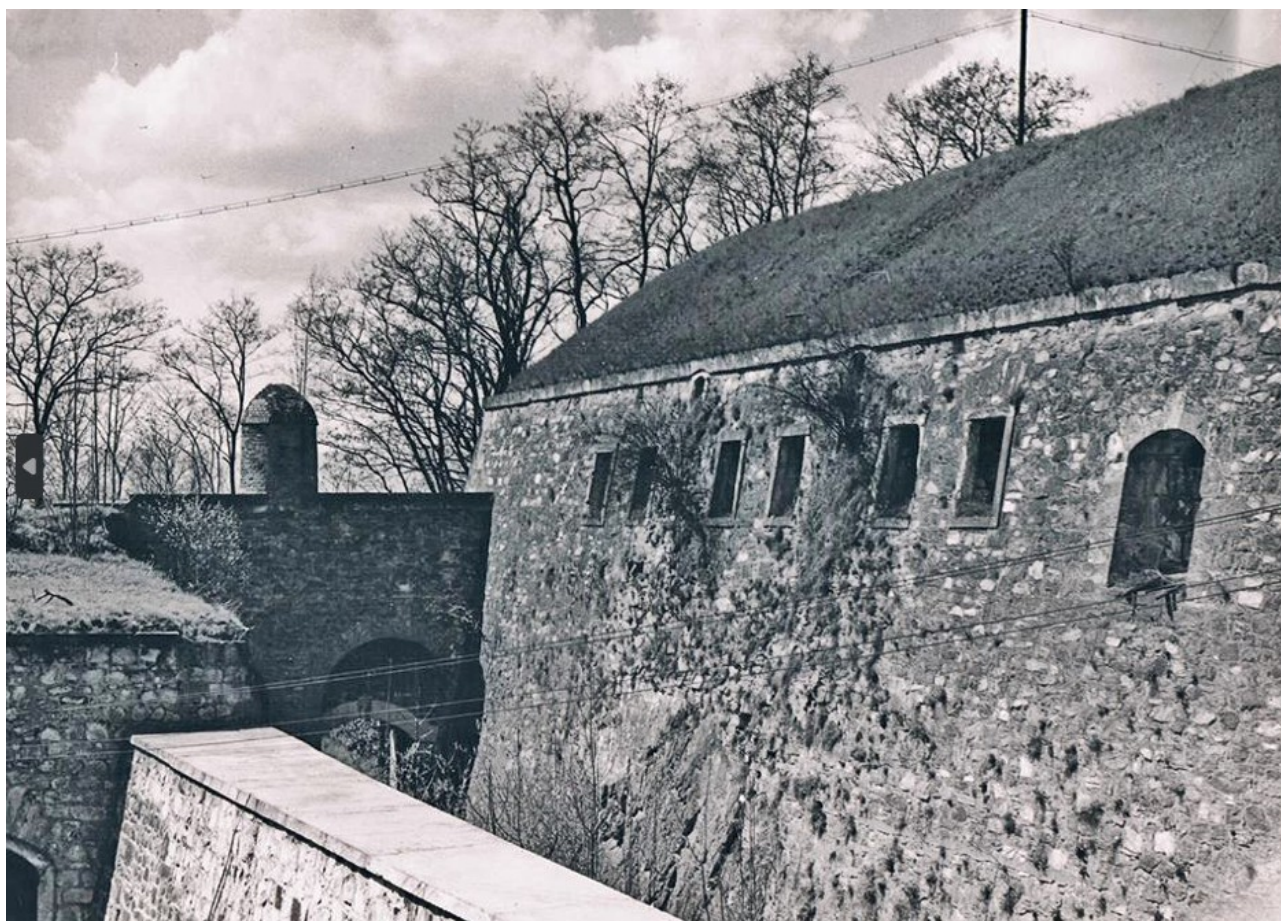
Widok południowej kurtyny do szpica nr 4 - pod koronowym gzymsem większe 2 otwory odwodnienia kanałów pachowych i mniejsze wentylacyjne – oddymiające.
