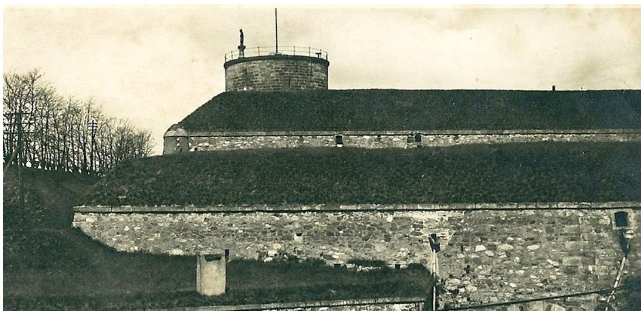
Widok południowej kurtyny od szpica nr 4 -pod koronowym gzymsem większe otwory odwodnienia kanałów pachowych i mniejsze wentylacyjne – oddymiające.
