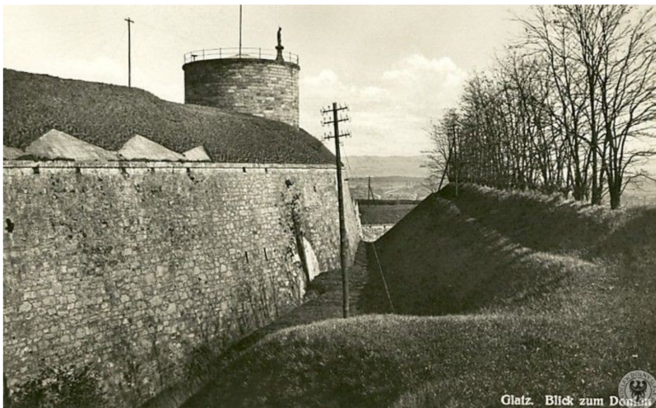
Widok zachodniej kurtyny. Czytelne podwyższenie dosdanów powstałe wskutek nadbudowy windą działową z przewyższeniem wału ziemnego ponad stropem (k. XIX w.)
