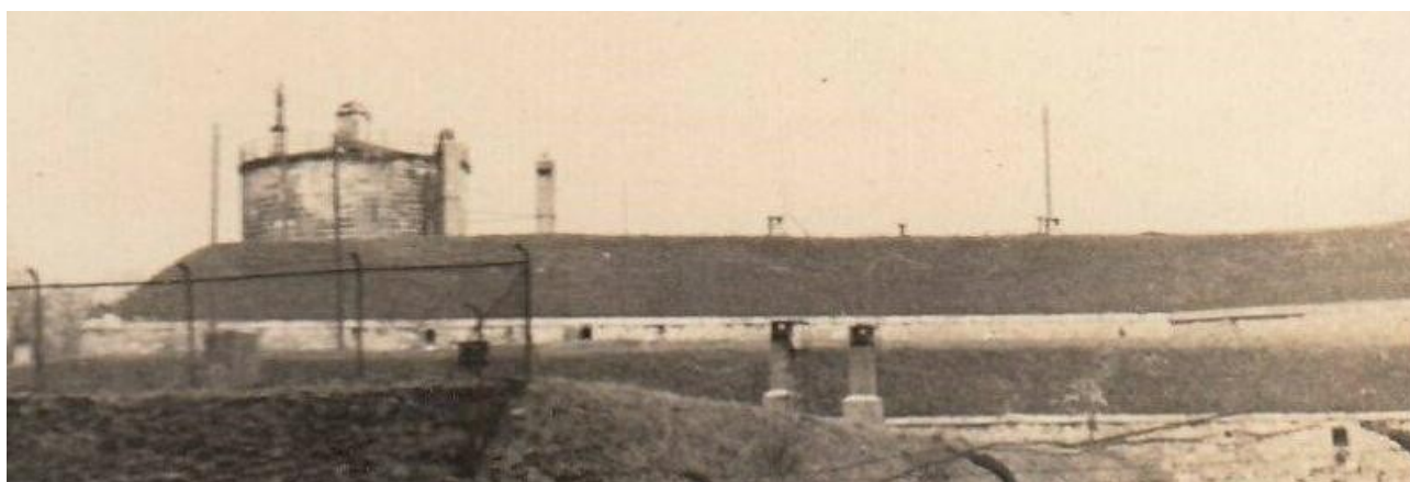
Widoczna południowa kurtyna Donjonu od zewnątrz z wieżą za szpicem nr 4. Dwa wtórne kominy przy wieży do obniżenia, pozostałe do odtworzenia w formie historycznej z 1943 r. Uwaga! Część kominów tynkowana część nietynkowana. Widocznej pod gzymsem koronowym otwory kanałów pachowych odwadniających szpic 4 i część kurtyny południowej na zewnątrz Donjonu oraz kanały oddymiające działobitni (prostokątne otwory).
