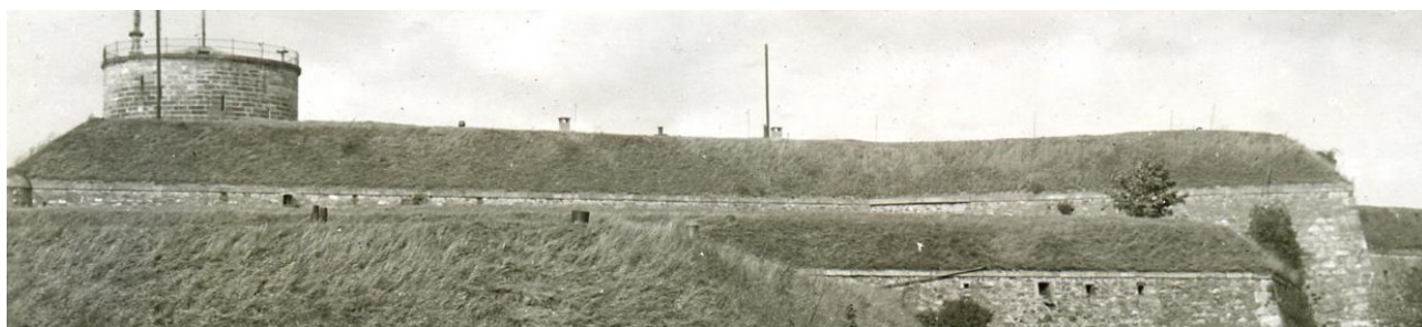
Widok całej południowej kurtyny od szpica nr 4 do szpica n 5 Donjonu. Widoczne kominy w dawnej wysokości i formie sprzed przebudowy w latach 30 XX w. po prawej widoczne przewyższenie czapy ziemnej nad stropem kojca strzeleckiego w szpicu nr 5.
